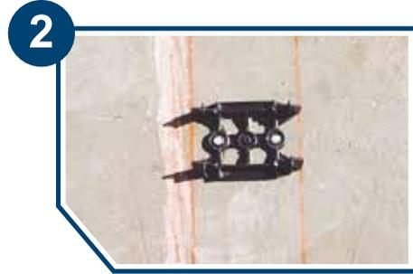
3. Al colocar los clavos se debe de cuidar que el alineador quede en la posición exacta sin salirse del trazado de tal manera que ayude a agilizar el armado de la cimbra.
