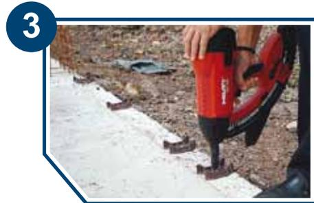
4. Utilizando la herramienta de fijación será más rápida la instalación de los alineadores, además de que las losas no sufren de las fracturas que en la mayoría de los casos se provocan al golpear con un marro.
