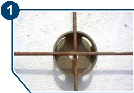
2. Una vez colocadas quedan en posición vertical y apoyadas sobre la base o cimbra. Cada silleta tiene una capacidad de carga de 200 kg.
