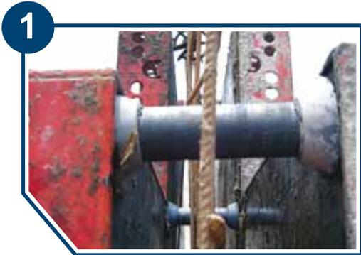
2. Se utilizaran en cada tensor de la cimbra a manera de fundas para después de colado el muro poder abrir la cimbra y recuperar los tensores.
