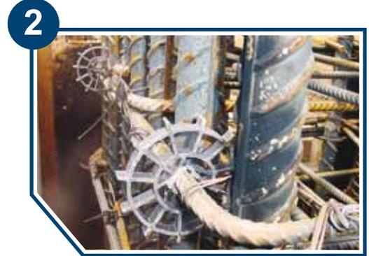
3. En muros con doble armado se deberán colocar dos piezas paralelas en ambos lados del armado.
