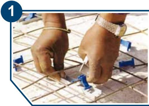
2. Ya ensambladas funcionarán correctamente, dándole suficiente superficie de apoyo. En el caso de utilizarse sobre casetón de poliestireno, éste deberá de ser al menos densidad 12.
