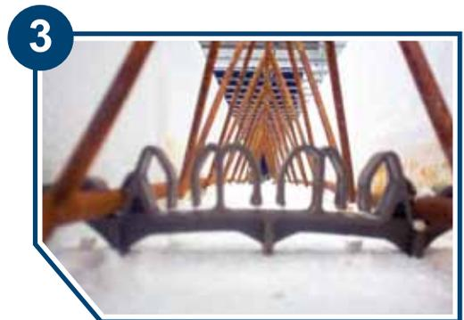
NOTA: El separador debe de ser utilizado en los extremos y en la zona central de la vigueta evitando colocarlos en las cortantes o zonas de mayor esfuerzo.
