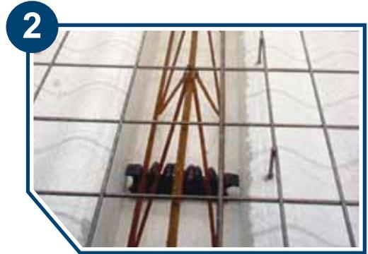
3. Se pueden colocar hasta tres varillas de refuerzo adicionales en el separador.
