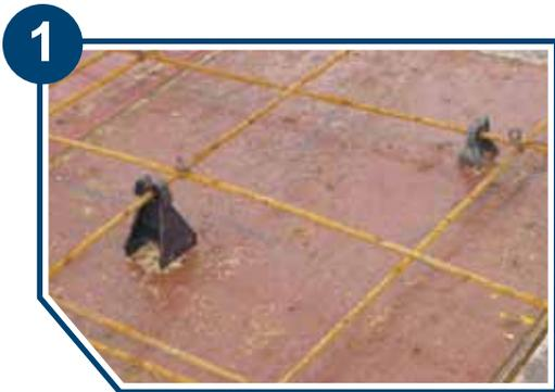
2. Una vez colocada debe de quedar completamente vertical y apoyada sobre la base o cimbra. Cada silleta tiene una capacidad de carga de 200 kg.
