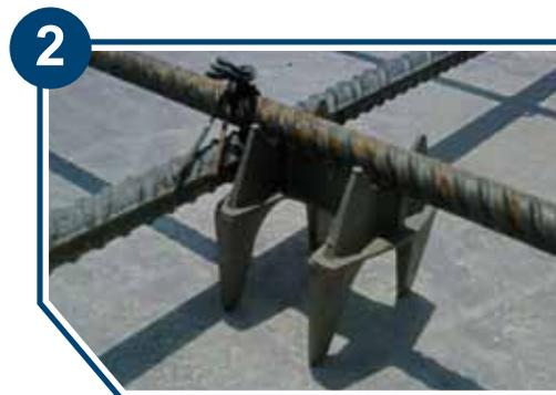
3. Las piezas deben quedar distribuidas de acuerdo a la forma o configuración de la estructura de refuerzo.
