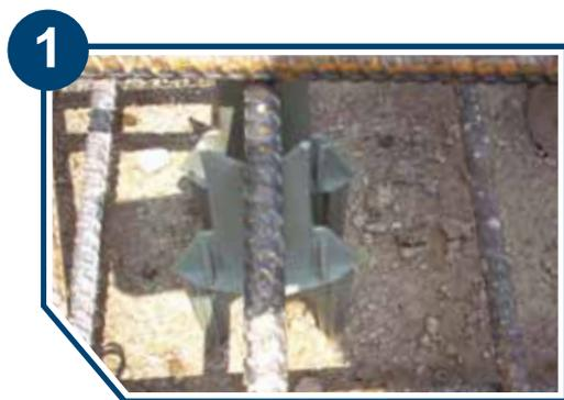
2. Es importante que las silletas estén distribuidas máximo 60 a 90 cm de distancia traslapándolas, dependiendo del peso del armado del acero de refuerzo. Cada silleta tiene una capacidad de carga de 275 kg.
